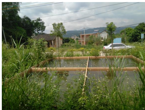
锅炉用水循环池
